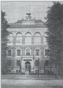
41. Gebäude der Artillerie-Prüfungskommission zu Berlin.
