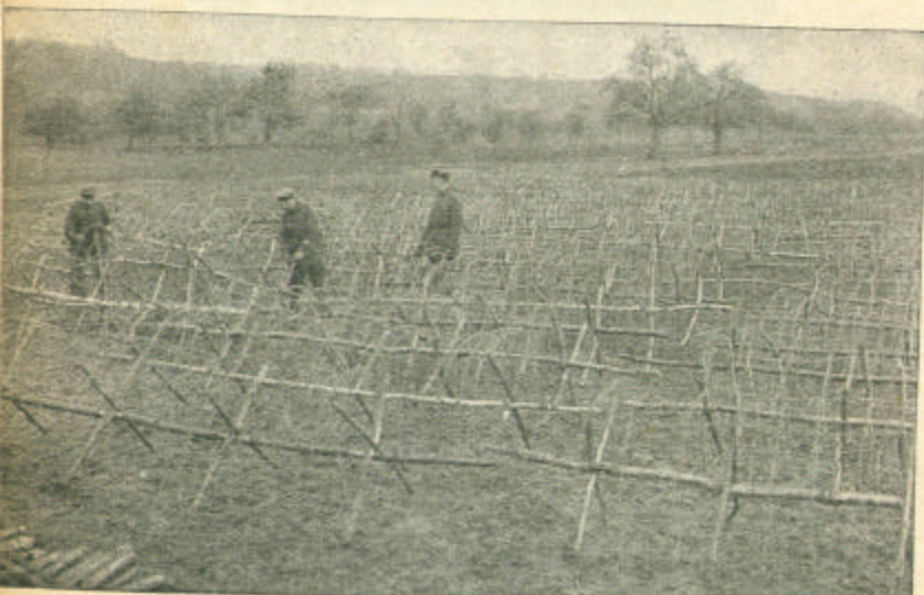
Bild 16. Bau von Drahthindernissen.
